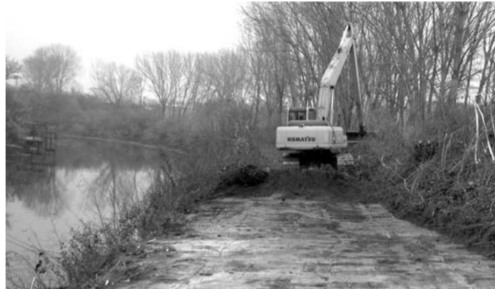
Уређење десне обале Великог бачког канала
