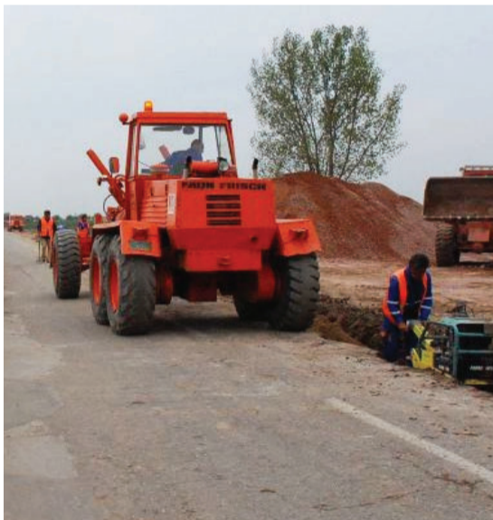
Radovi na rekonstrukciji puta Stanišić - Svetozar Miletić
